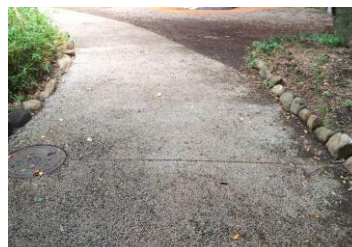
透水性舗装(岡本公園)
