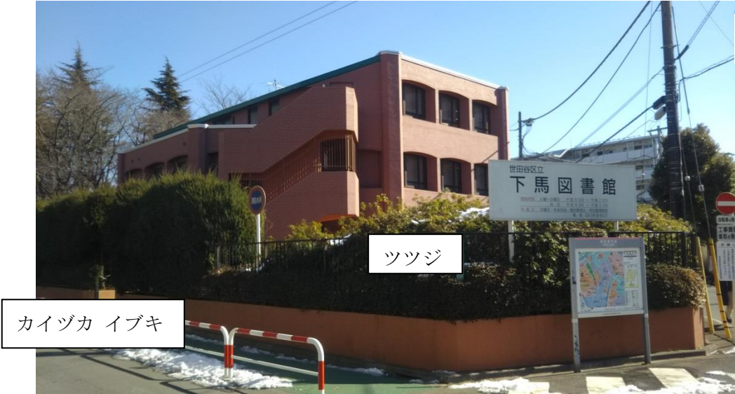
写真④ 敷地の北東面
