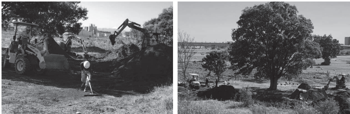
写真 53・54: 地域の土木会社（株）マモルさんによる重機での作業応援
