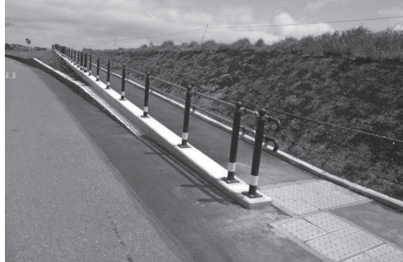
写真 13: 国の工事で完成した土手スロープ
