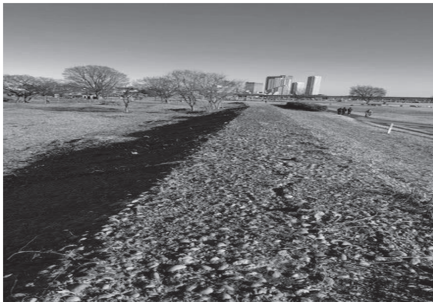
写真 30: 霞堤と思われる河川敷内の旧堤防
