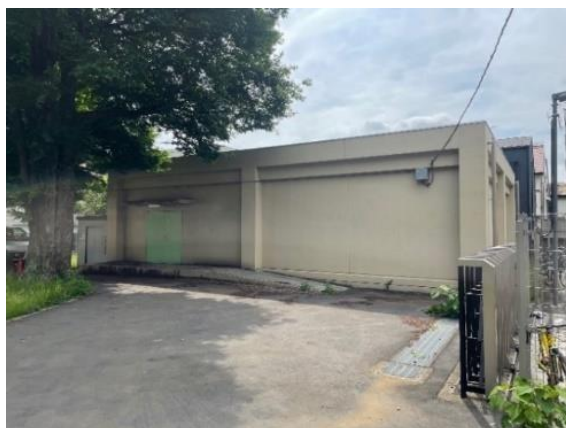
広域用防災倉庫(世田谷四丁目)
