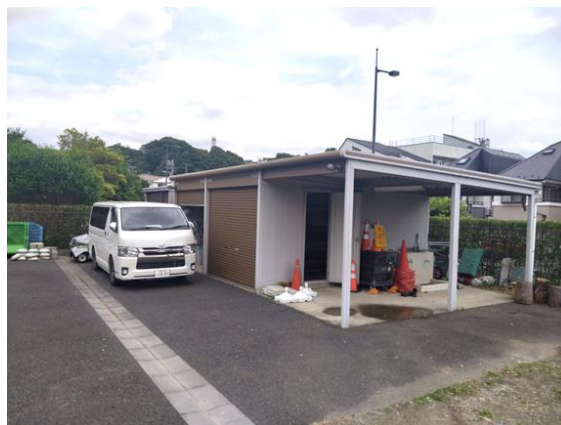
公園管理施設(二子玉川公園)
