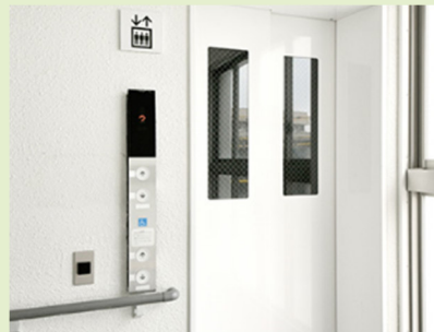
③タッチレスエレベーター
