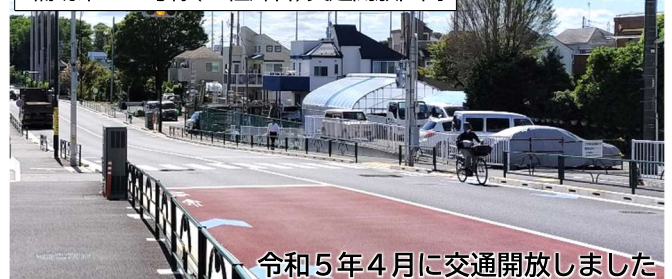
補助第54号線(上祖師谷)交通開放区間
