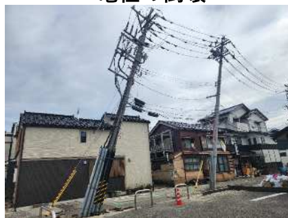
電柱の倒壊
