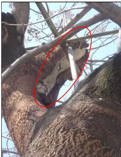
写真1 上部丸太支柱劣化 大枝: 開口空洞、腐朽
