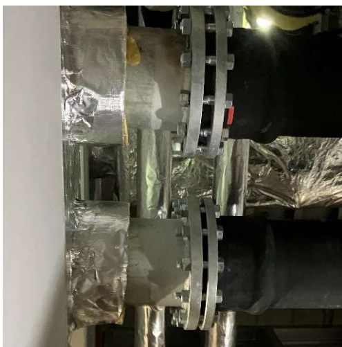
集中豪雨に対応可能な免振可動部の雨水配管継手
