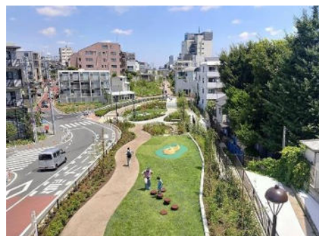
整備された小田急線上部空間
