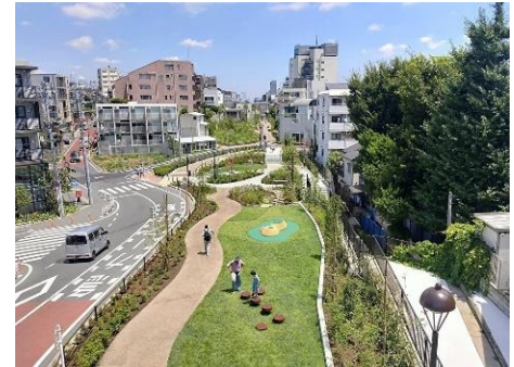
整備された小田急線上部空間
