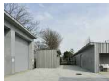
バックヤード・防災倉庫
