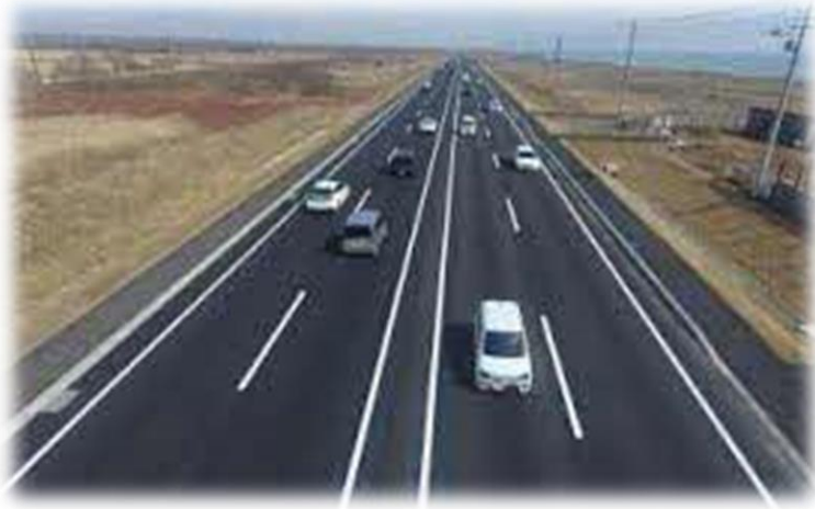
国道36号(社台)の拡幅
