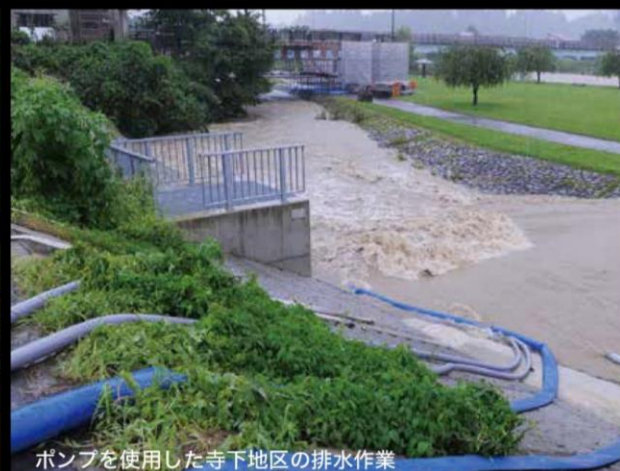
ポンプを使用した寺下地区の排水作業
