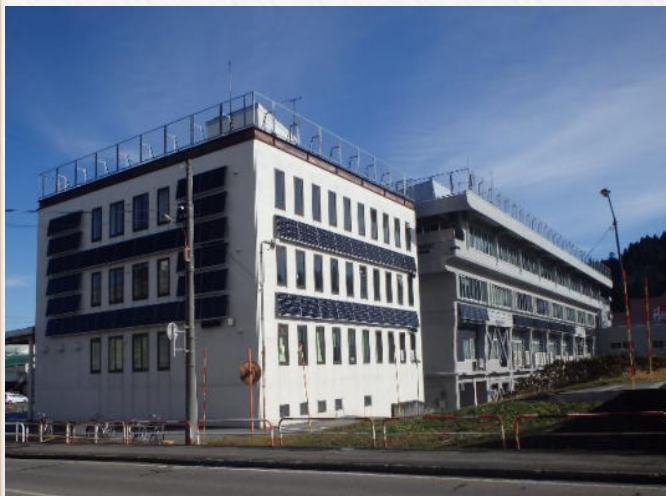
市役所本庁舎（27.5kW）
