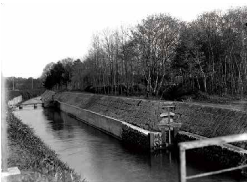
上流より見た烏山用水の取水口 （大正～昭和前期）
