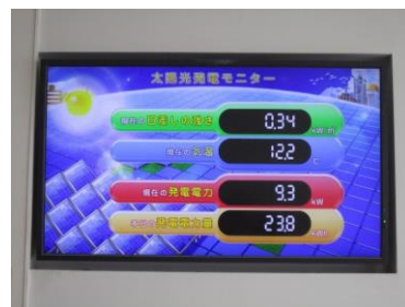
発電状況等モニターの例
