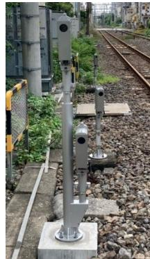
図 89 従来のレーザー式障害物検知装置
