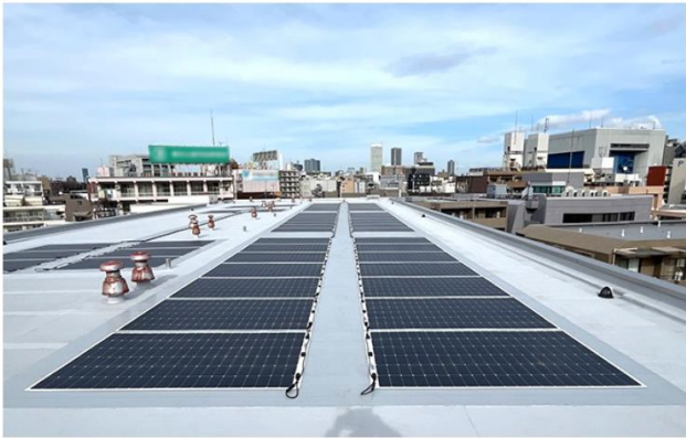
従来の基礎や支持架台ではなく、接着剤を用いてアスファルト防水層の屋根に「超薄型軽量パネル」を貼り付ける工法
