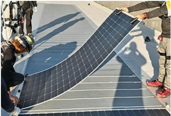
接着剤を用いた超薄型軽量パネルの貼り付け状況
