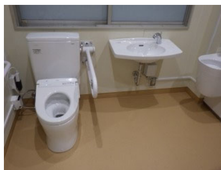
写真4-2 バリアフリースペースの設置
