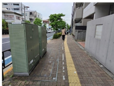
写真 4-4 無電柱化した歩道
