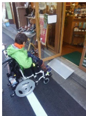
写真 2-8 店舗への取り外し可能な簡易スロープの設置
