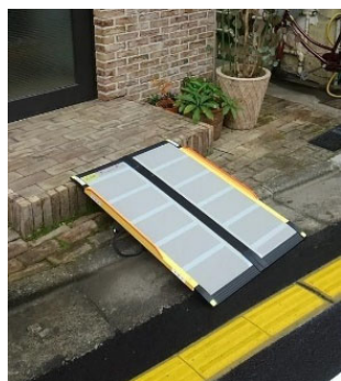
写真 4-11 補助事例 (段差解消用簡易スロープ)
