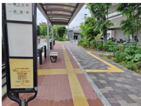
写真 4-3 歩道と施設の敷地の段差解消、 連続した誘導用ブロックの敷設 （小田急梅ヶ丘駅周辺）
