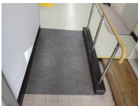
写真4-1 段差部分にスロープ、手すりを設置
