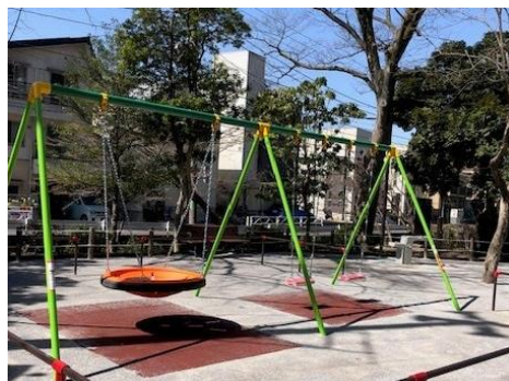
インクルーシブ遊具※を設置した公園 (区立岡本公園)
