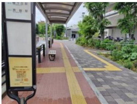
歩道と施設の敷地の段差解消 連続した誘導用ブロックの敷設 (梅ヶ丘駅周辺)
