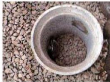
雨水浸透ます
