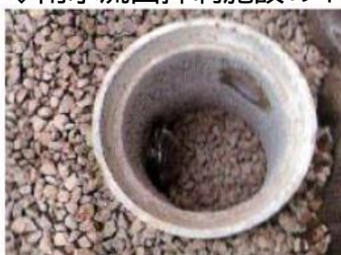
雨水浸透ます
