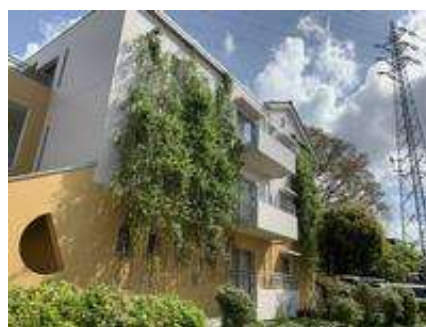
深沢環境共生住宅 3号棟の壁面緑化
