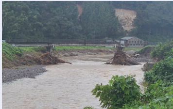
▲豪雨で倒壊した橋の様子(10月3日、輪島市)
