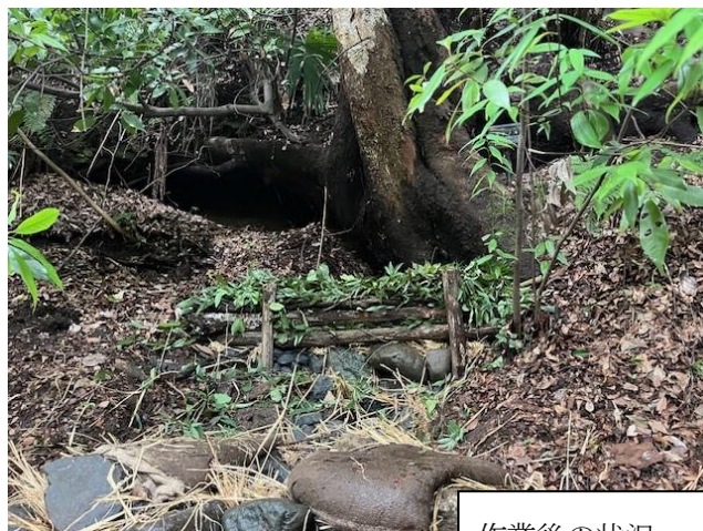
作業後の状況
