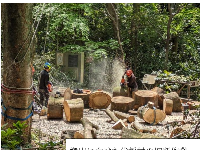
搬出に向けた伐採材の切断作業
