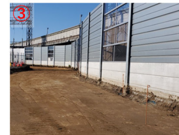
ランプ橋部 下部工防音パネル設置状況 （令和6年11月撮影）
