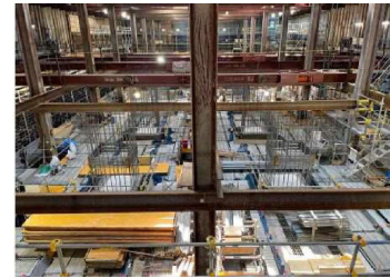
換気所地下構造物の立坑内の状況(床付け) (令和6年4月11日)
