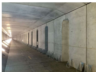
内部構築工の状況 (令和6年5月30日)
