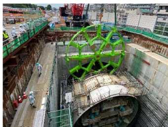
シールドマシンの組立状況 (令和3年6月21日)
