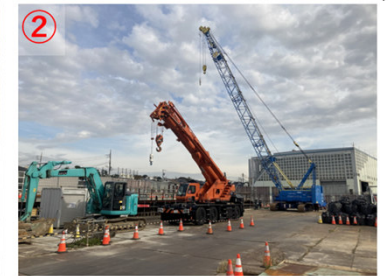
開削部 Hランプ工事状況 （令和6年11月撮影）
