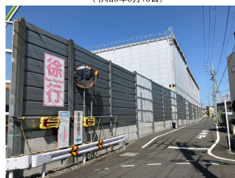
土砂ビットヤードの状況（世田谷通り方面から望む） (令和6年5月17日)
