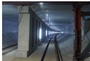
内部構築工・仮設床版の状況 (令和6年4月25日)
