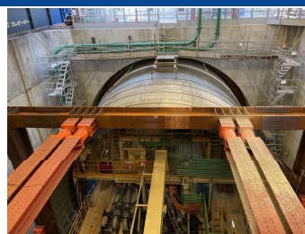
発進立坑部の状況 (令和6年4月18日)
