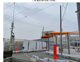
土砂ビットヤードの状況（世田谷通り方面から望む） (令和6年4月18日)
