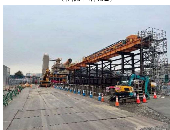
土砂ビットヤードの設置状況 (令和6年4月18日)
