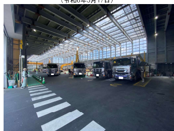
土砂ビットヤードの内部状況 (令和6年5月15日)
