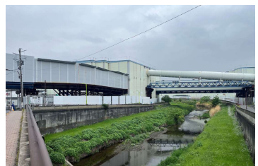
土砂ビットヤードの全景写真 (令和6年4月25日)
