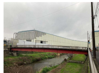
土砂ビットヤードの全景写真 (令和6年3月26日)
