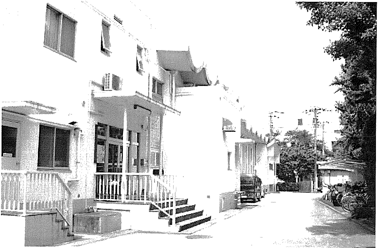
現在の調理場（写真手前が玄関、左奥に給食配送車の車庫、右奥に調理場の門があります。）
