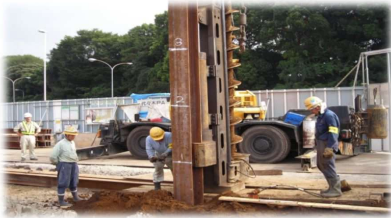
重機による山留材挿入
