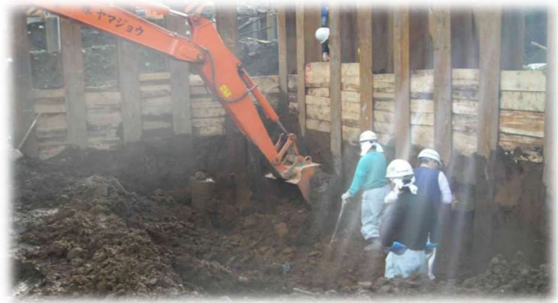
重機による掘削
