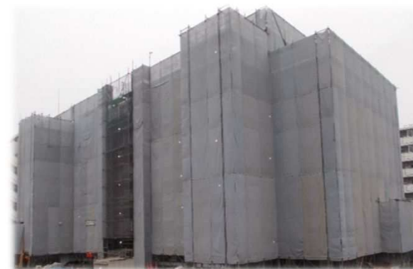
足場設置（Ⅰ期工事） 枠組足場（養生シート）
