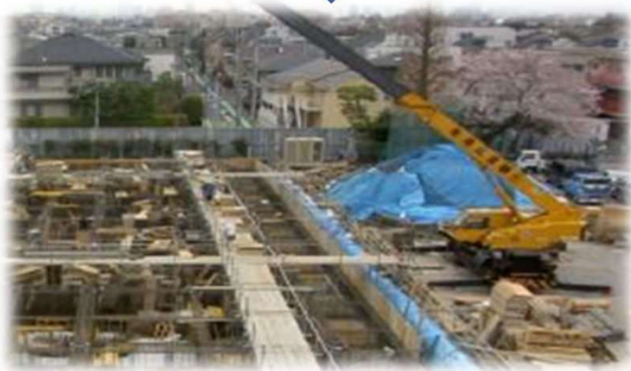
躯体配筋・型枠建て込み
