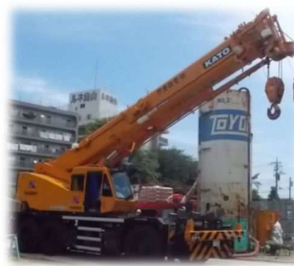
ラフテレーンクレーン
