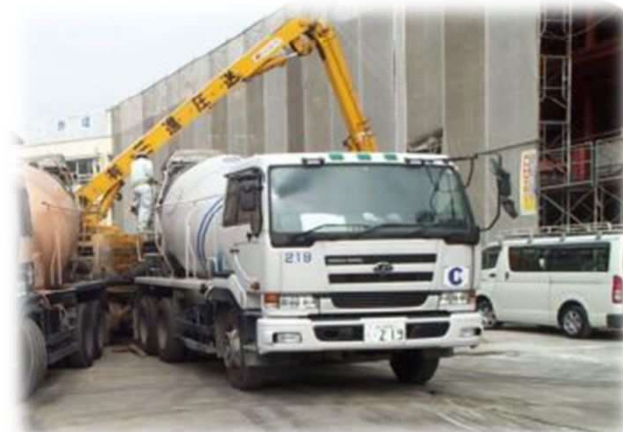
コンクリート打設
