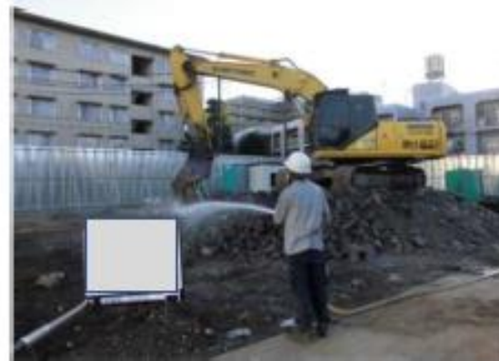
コンクリートの小割作業
