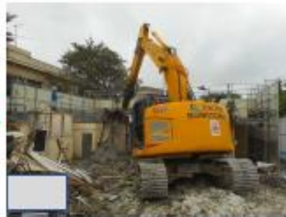
建屋解体（壁倒し）
