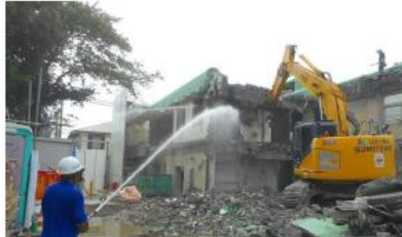
散水作業状況
