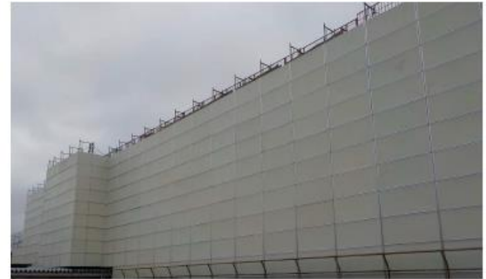
防音パネル（枠組足場）
