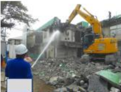
建屋解体（中抜き）
