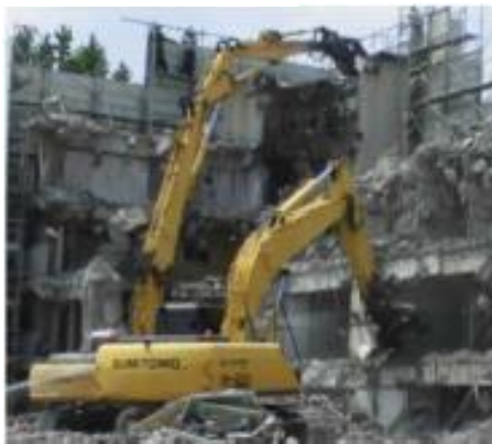
重機による解体作業
