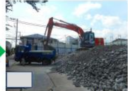
廃材搬出（コンクリートくず）
