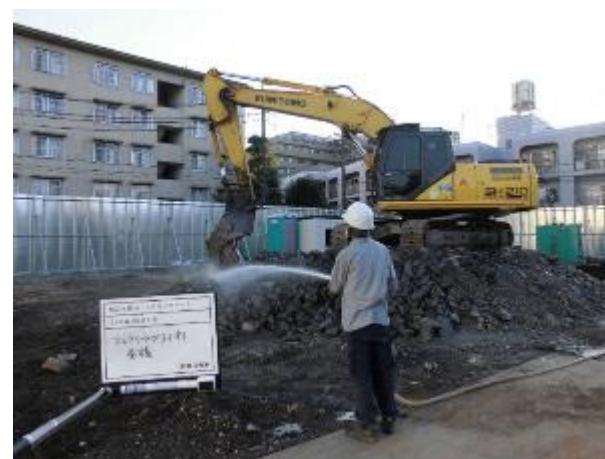
▲コンクリートガラ小割作業（参考写真）
