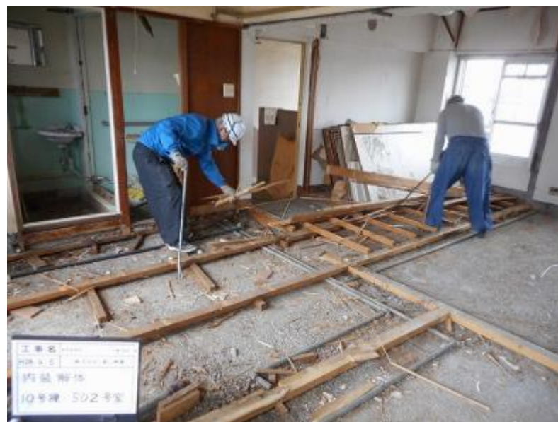
▲内装解体（参考写真）
