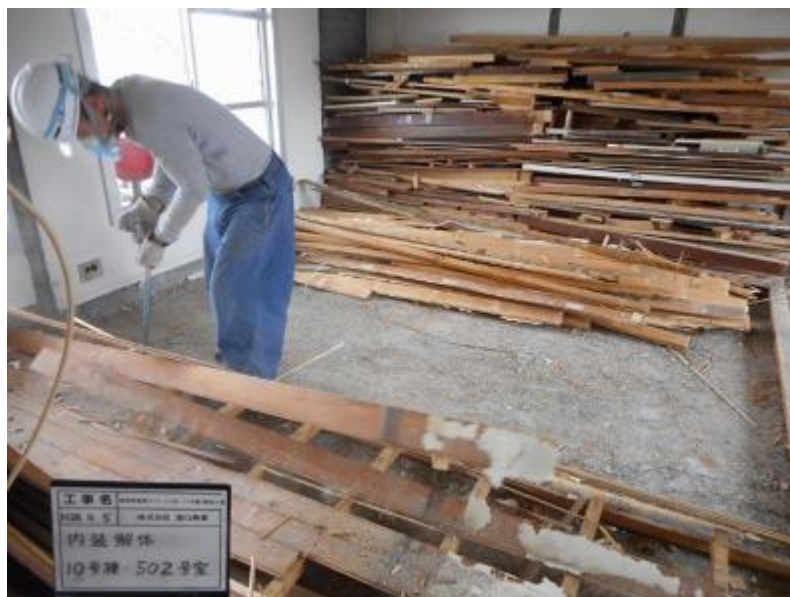
▲内装解体（参考写真）
