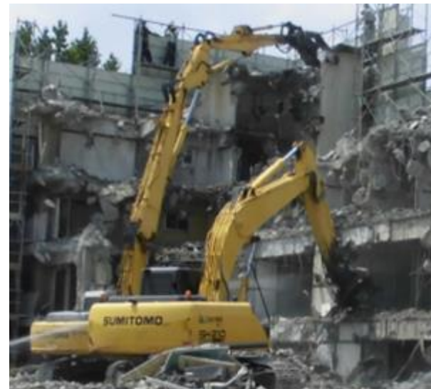
▲重機解体（圧砕工法）（参考写真）
