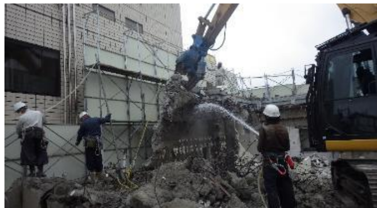
▲散水作業(参考写真)
