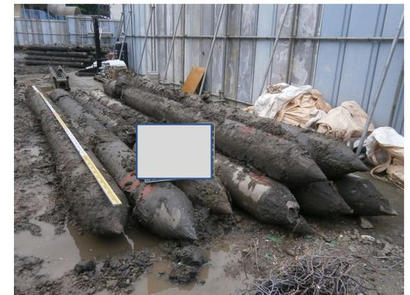
PC杭引き抜き後 (寸法計測)
