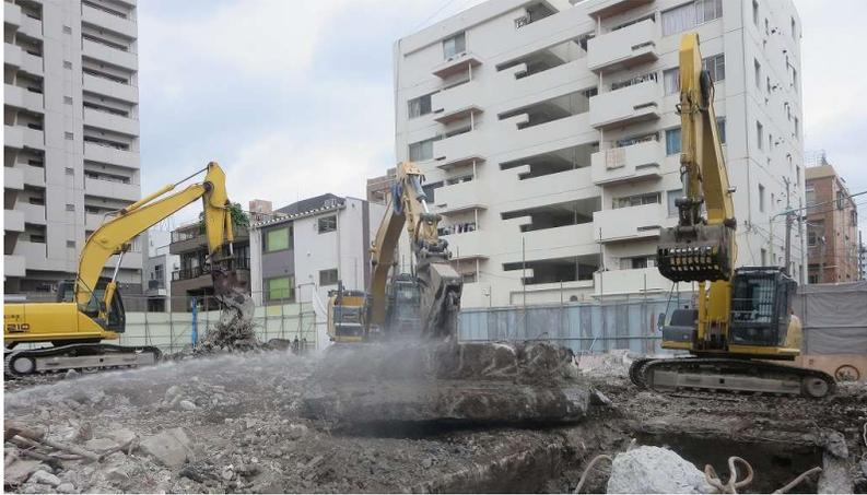
基礎解体 (掘削後掘り起して解体)
