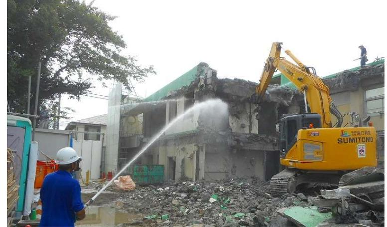
上屋解体 (圧砕工法) 及び散水状況
