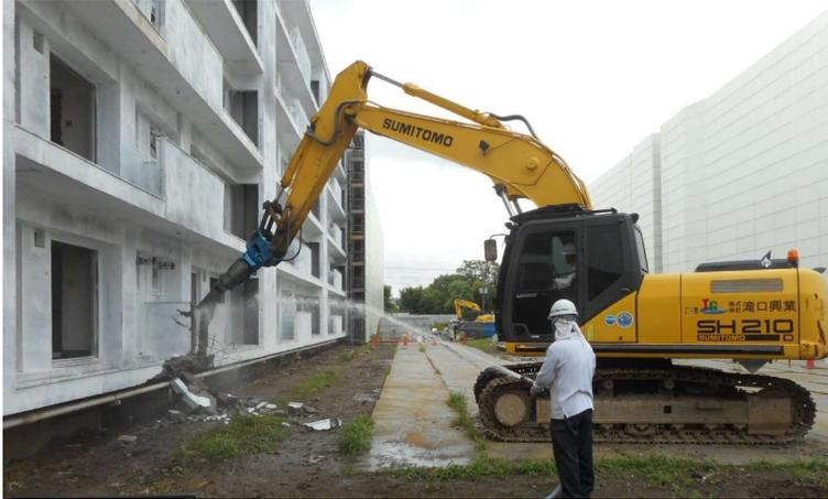
上屋解体 (圧砕工法) 及び散水状況
