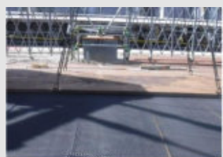
敷鉄板+建設振動低減材
