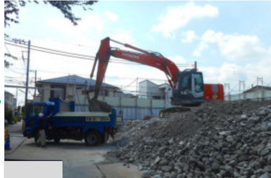
解体発生材搬出(コンクリートガラ)
