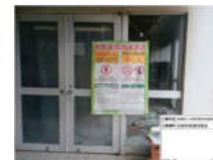
作業中看板設置
