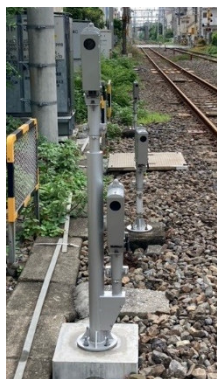
図 88 従来のレーザー式検知装置
