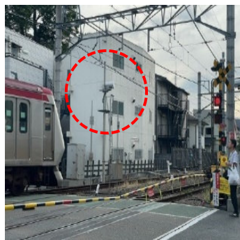
図 89 3D障害物検知装置
