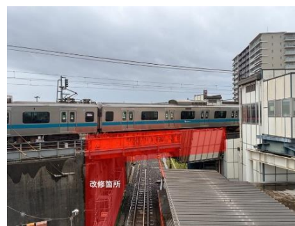
ＪＲ相模線跨線橋耐震補強工事箇所
