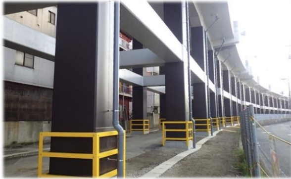
《高架橋耐震補強》
