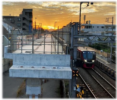
《高架橋躯体(千歳烏山～仙川駅間)》
