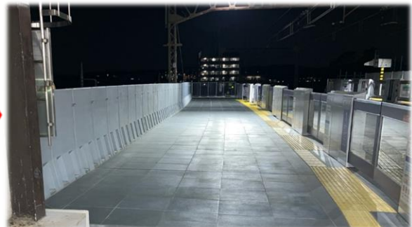
《ホーム改修施行後(京王多摩川駅)》
