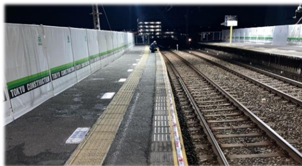
《ホーム改修施行前(京王多摩川駅)》
