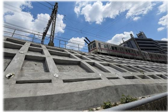
《線路脇法面改修(豪雨災害対策)》
