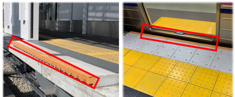
《転落防止ゴム設置の様子》
