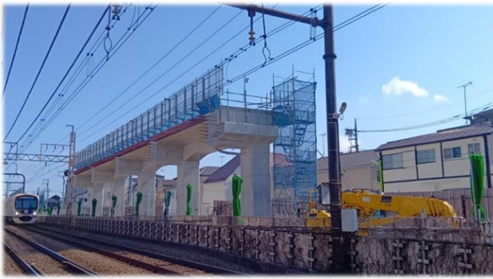
《高架橋躯体(明大前～下高井戸駅間)》
