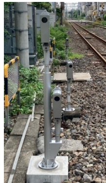
図 88 従来のレーザー式検知装置
