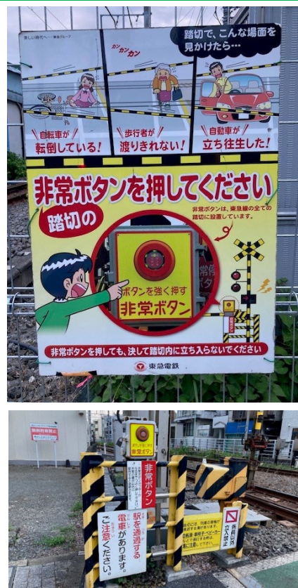
図 8-7 踏切の啓発看板と非常ボタンの例
