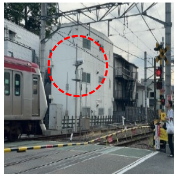
図 89 3D障害物検知装置
