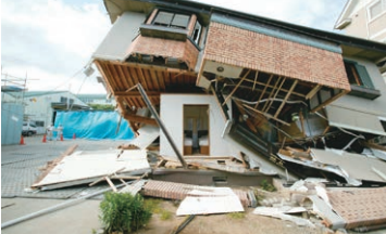
▲耐震シェルター
