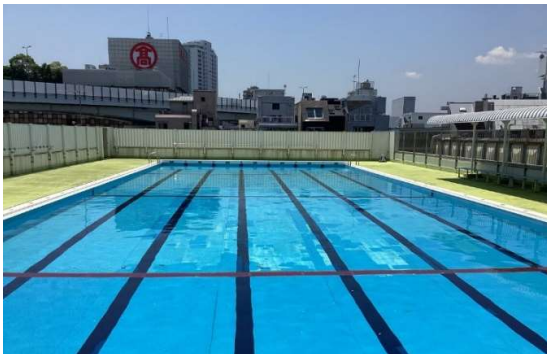
プール開始前に補修した様子
