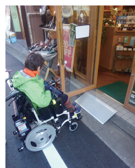
店舗への取り外し可能な簡易スロープの設置
