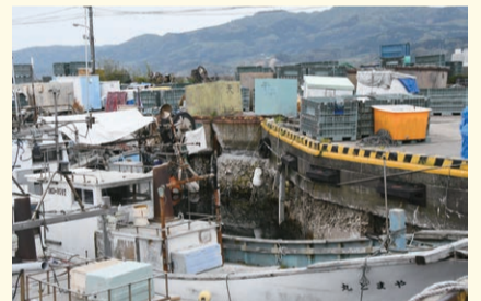
▲(輪島港)海底が約1.5m隆起して浅瀬となり、漁船が出港できない状況
