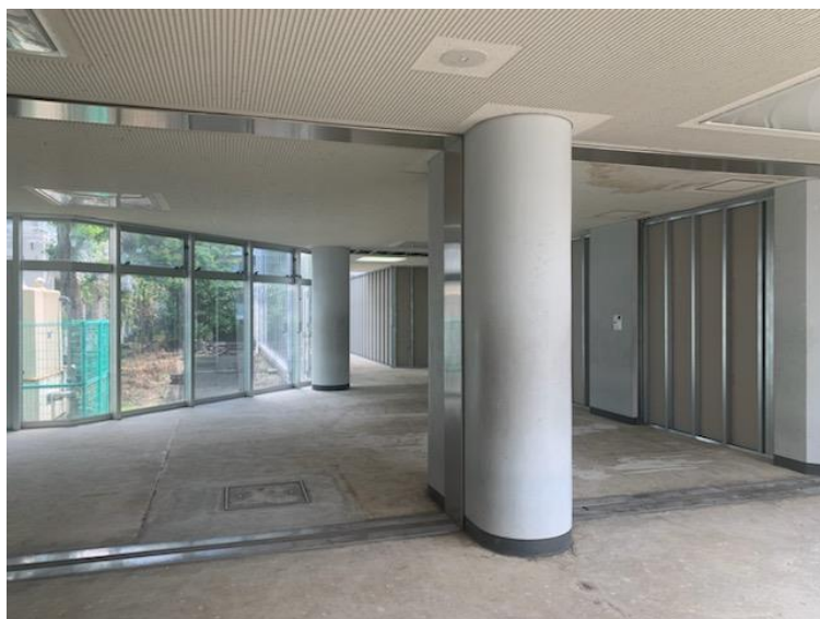
体育館棟内の工事状況
