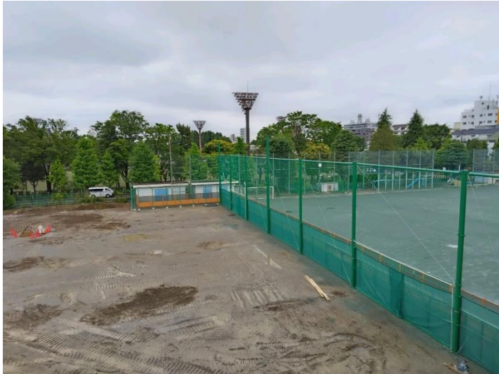
小学校との境界防球フェンス
