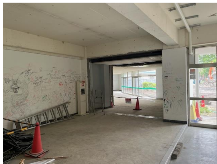
校舎棟と体育館棟間の一体化（壁の撤去）
