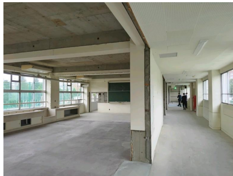
校舎棟内の工事進捗状況②
