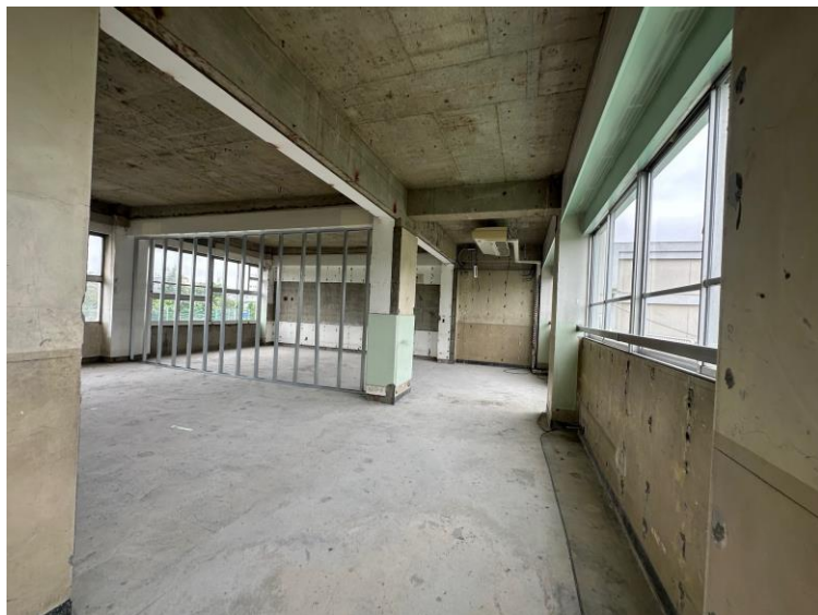
校舎棟内の工事進捗状況①
