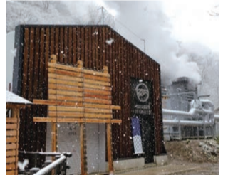
▲発電所「コミュニティ発電 ザ・松之山温泉」
