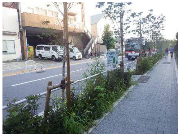
雨水貯留浸透する道路植栽帯 (区画街路7号線)
