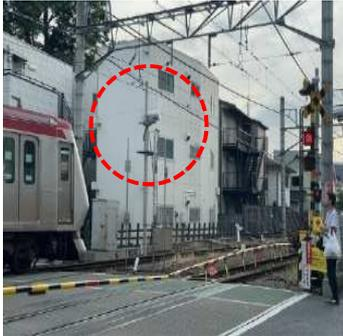
図 8 7 3 D 障害物検知装置
