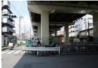
35 田中橋 (玉川台 1-13)
