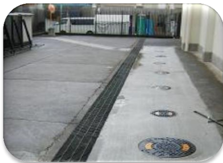
校内に設置されたマンホール
