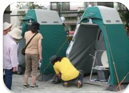
マンホールの上に設置したテント・便器
