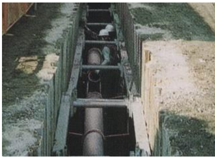
排水管設置状況
