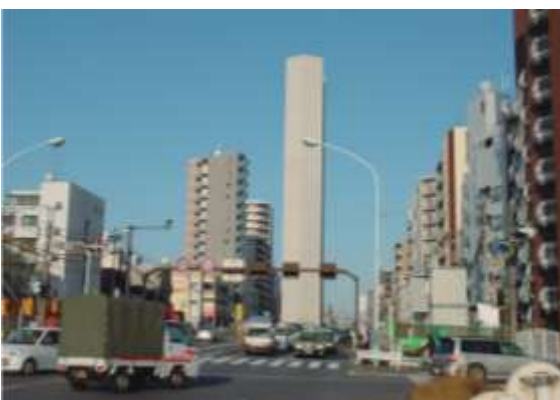
《落合換気所(首都高速道路中央環状線)》
