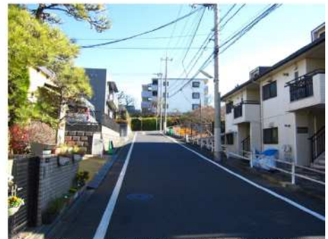
整備された区域内の道路（田直地区）
