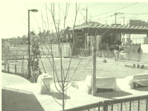
広場工事現場の風景
